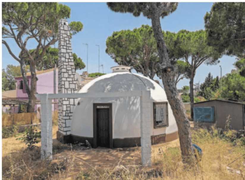
Ejemplo de una de las Casas del Ingeniero, en la Barriada Jarana (Puerto Real). PACO PUENTES
