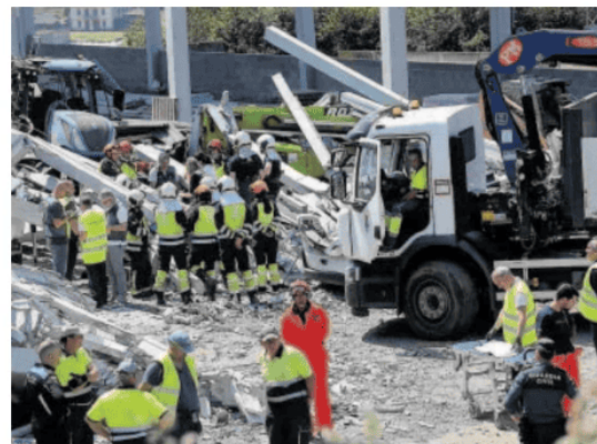
Trabajos ayer, tras el derrumbe en la nave de Coaña. J. L. CEREMJHO (EFE)
